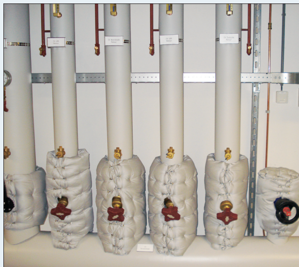
Appendages worden geregeld niet geïsoleerd. Door het gebruik van matrassen, die gemakkelijk op en af te zetten zijn, ligt de terugverdientijd tussen de zes maanden en twee jaar.
